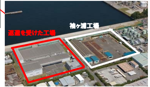
袖ヶ浦工場 (敷地面積各々6,000坪×2)
